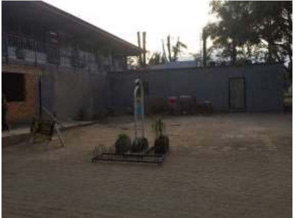
Vista obra en proceso.
