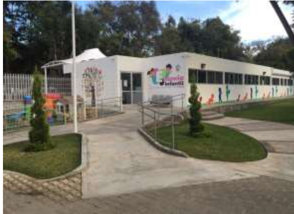
Vista de edificio de estancia infantil.
