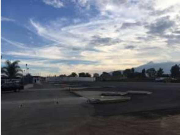
Vista área de estacionamiento.
