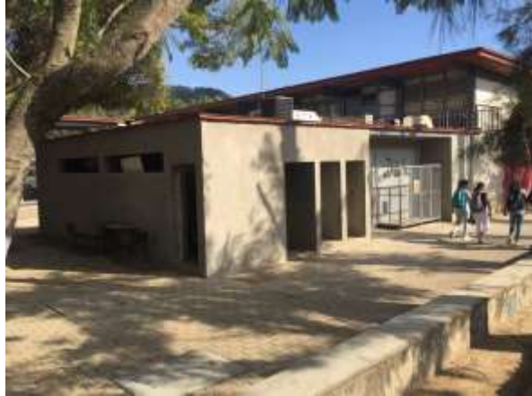
Vista obra en proceso.
