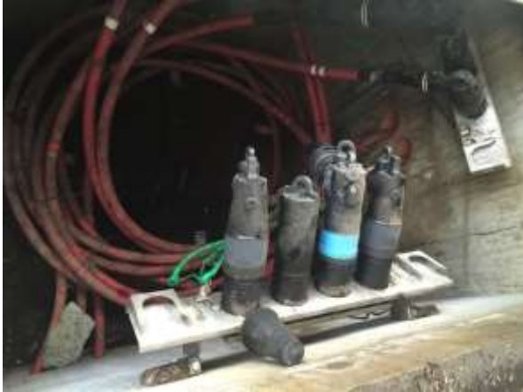
Vista de instalaciones/servicios.
