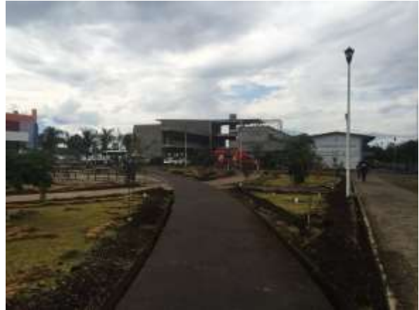
Vista de edificio en proceso de construcción
