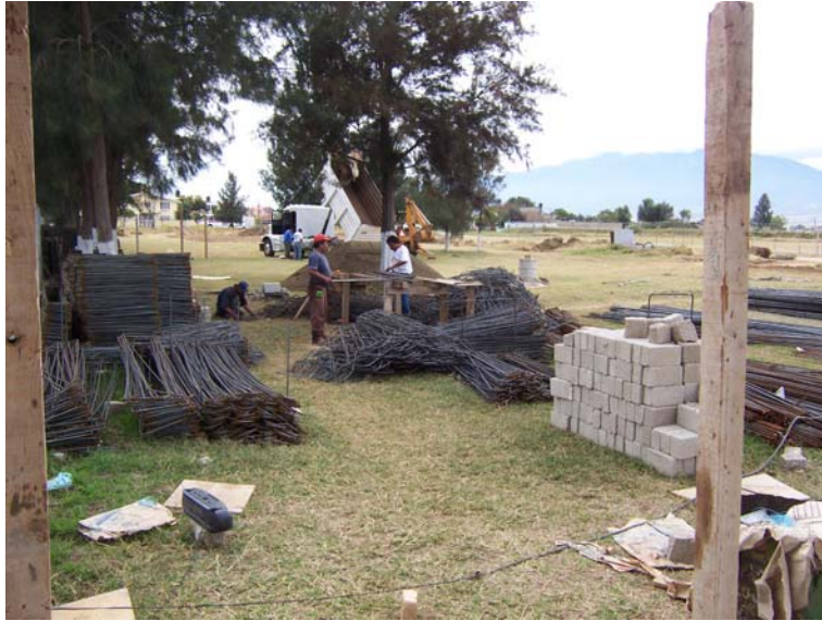
Material para construcción de la alberca semi-olímpica
