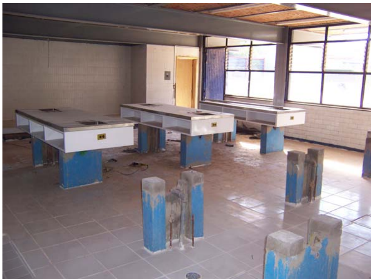
Remodelación de laboratorios
