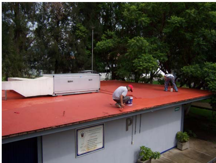
Impermeabilización de la Clínica- Escuela
