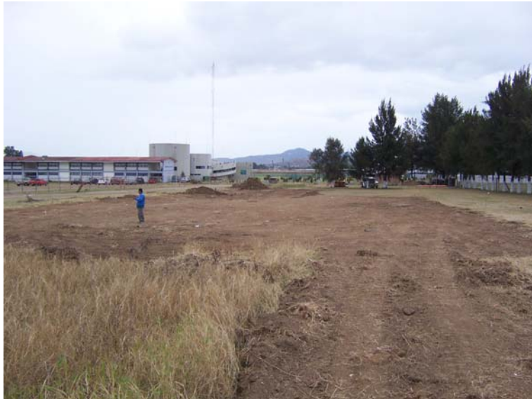
Preparación del terreno para alberca semi-olímpica
